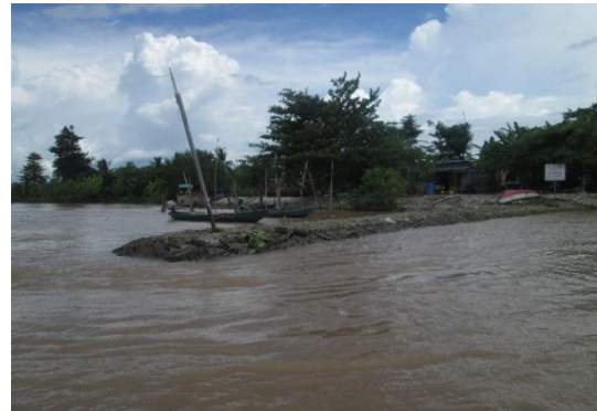
Hình 11. Một kè mở hàn khu vực xã An Hiệp, huyện Châu Thành [20].
